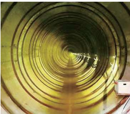
图 6 CCTV 检测成管
