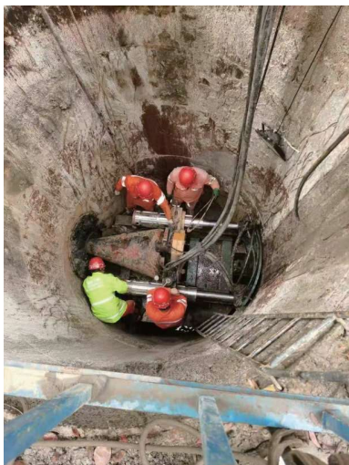
图 4 安装挤扩机头
