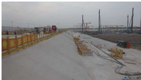
图 11 结构施工完成场地交付图
