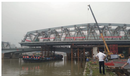
图2 钢桁梁浮托顶推施工现场
