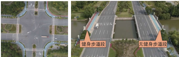
图 10 申港大道 - 环湖西三路交叉口转角、桥梁段改造后效果
