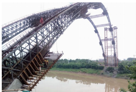
图 7 拱肋外包施工工作平台
