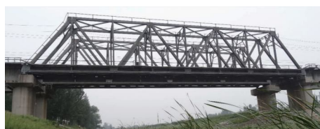
图 1 下承式简支钢桁梁桥全貌
