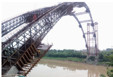
图 7 拱肋外包施工工作平台
