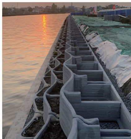
图 4 3D 打印预制构件现场照片
