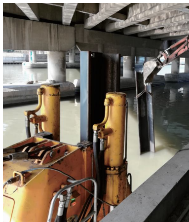
图 2 桥下段钢板桩静压法施工现场照片
