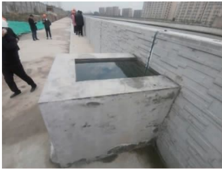
图3 装配式挡墙闭水试验现场照片
