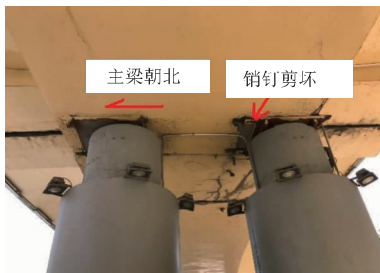
图 4 TD2 支座剪坏滑移之实景
