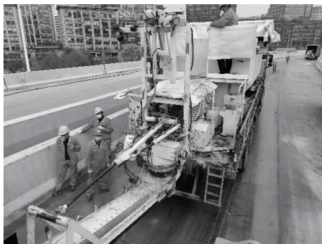
图 2 专用搅拌运输车之实景
