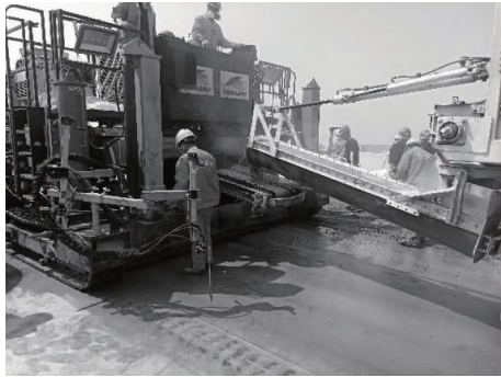
图 1 专用摊铺机之实景
