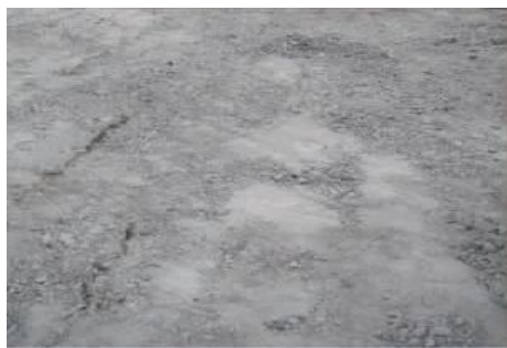
图3 共振破碎后面板
