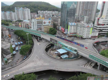
图1 鹅岭立交现状
