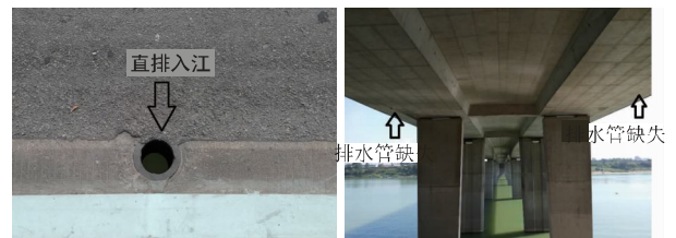
图 1 实桥排水系统现状照片
