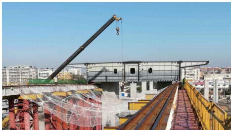
图6 中兴大桥边跨钢梁滑移图
