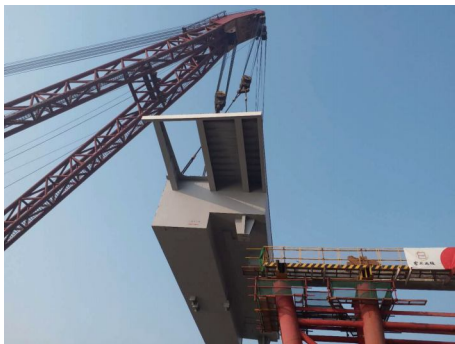
图5 中兴大桥边跨钢梁吊装图
