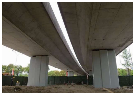
图 4 空港立交 P 线桥改造后实景图
