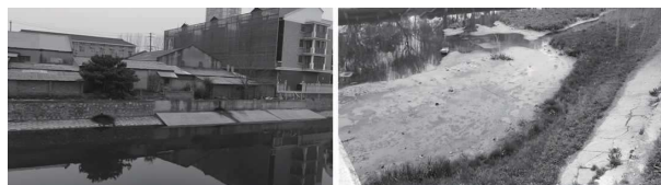
图 3 南河岸坡硬化和水体黑臭(2016 年)
