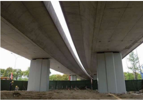
图 4 空港立交 P 线桥改造后实景图
