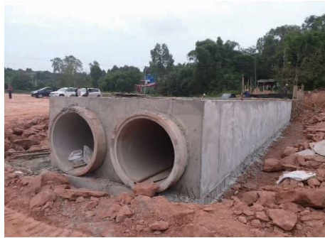
图7 管廊内管线过街管涵
