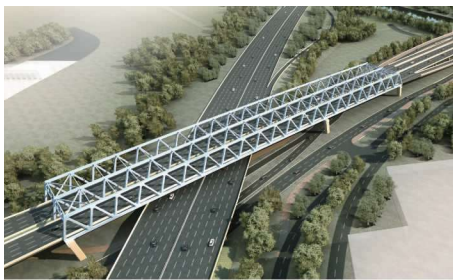
图 1 跨沪宁高速(165+90)m 钢桁梁整体效果图
