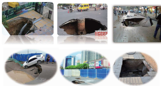
图1 道路塌陷实图
