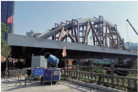
图 2 梁拱临时支撑现场照片
