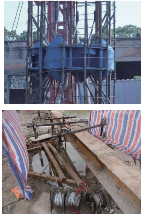
图5 现场试验之实景
