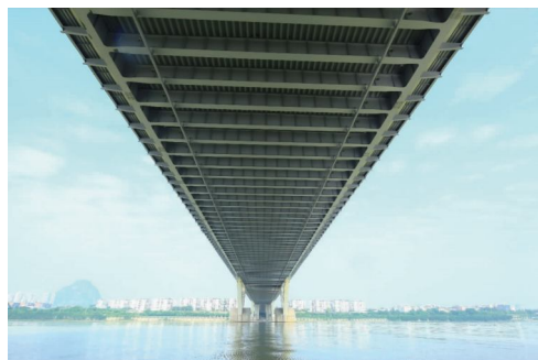
图5 桥面加劲梁照片
