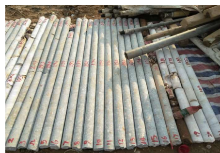
图4 右幅11#-3桩基3#孔芯样图
