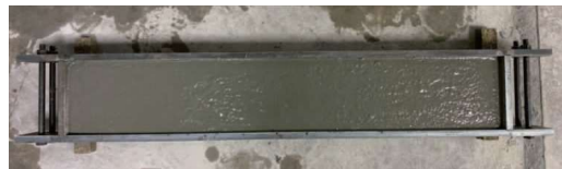
图7 浇筑UHPC层并养护
