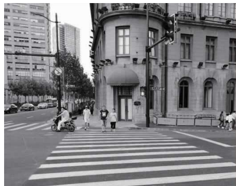
图1 某道路合杆工程
