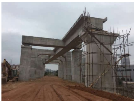
图3 国内某类似工点施工时的照片
