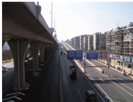
图3 石闸立交SZ2号匝道现场照片
