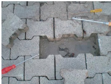
图4 填缝料迁移堵塞找平层
