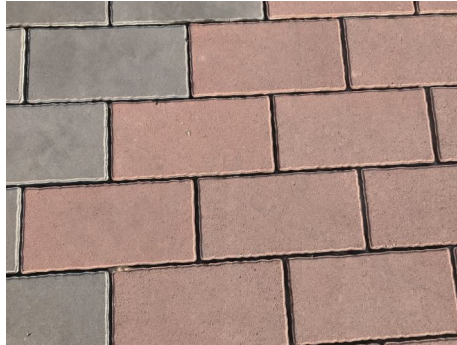
图3 填缝料被冲刷迁移
