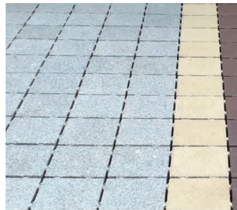
图 2 缝隙透水型路面
