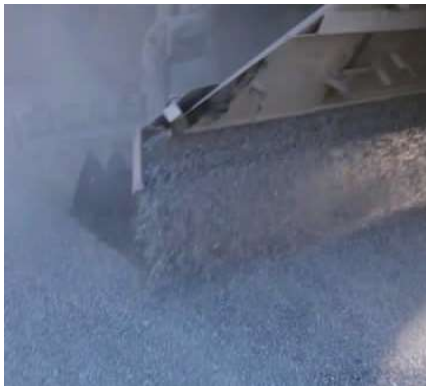
图 3 同步封层车施工
