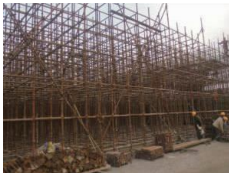
图6 支架搭设现场
