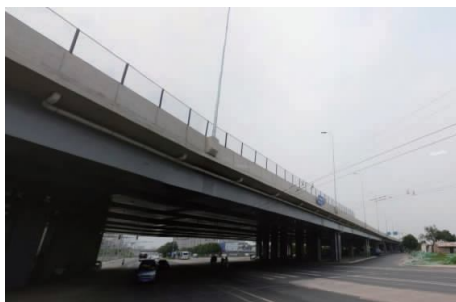
图3 瀛海镇高架桥成桥
