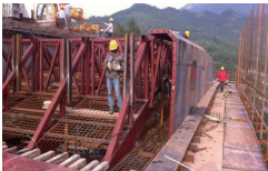
(a)平联、模板面板的安装
