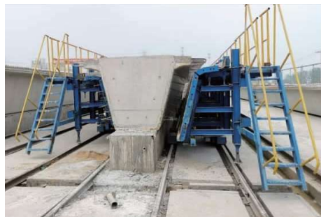
图1 移动液压钢模板之实景
