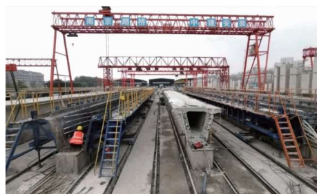
图4 箱梁预制生产线之实景
