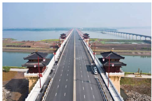
图6 海子湖特大桥建成实景图
