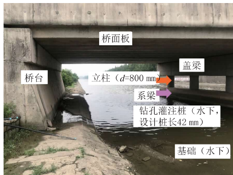
(b)桥的结构组成构件结构
