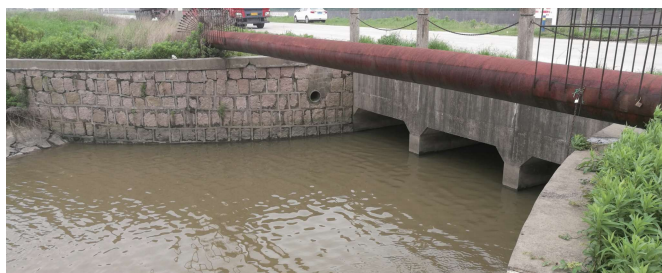
图 1 围场支路便道桥现场照片
