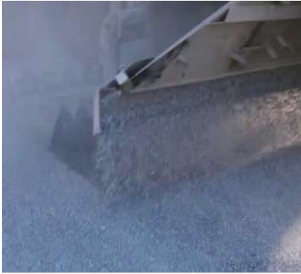
图3 同步封层车施工
