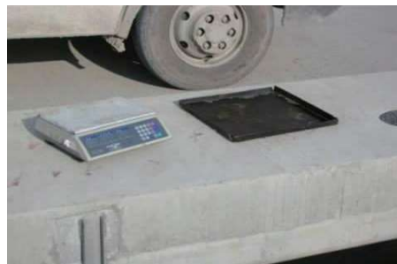
图5 现场沥青量检测
