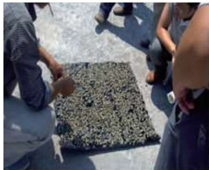
图6 碎石撒布量检测
