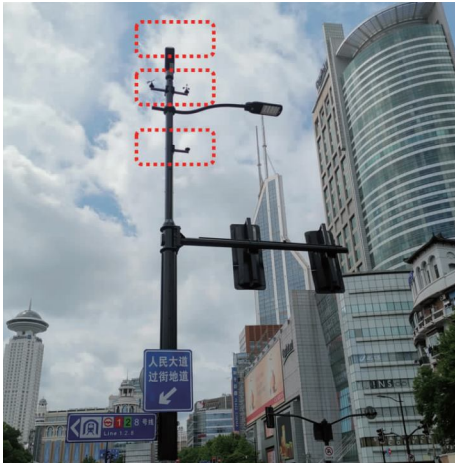
图 9 综合杆上安装 5G 微基站、气象设备、传感器等智能设备 个部门,协调难度大,成立指挥部可有效提升协调力度和效率。此外由于每条道路地下条件不同、道路设施不同等原因,针对每条道路实现“一路一方
