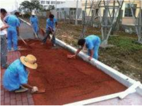
图 7 透水混凝土铺平作业之实景
