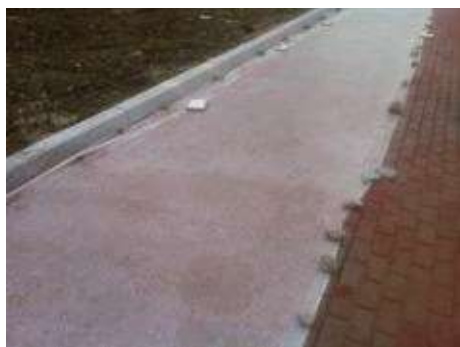
图 11 透水混凝土养护之实景
