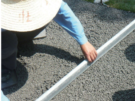
图 10 透水混凝土细平作业之实景
