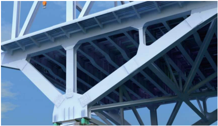
图 6 密横梁形式的整体桥面板
