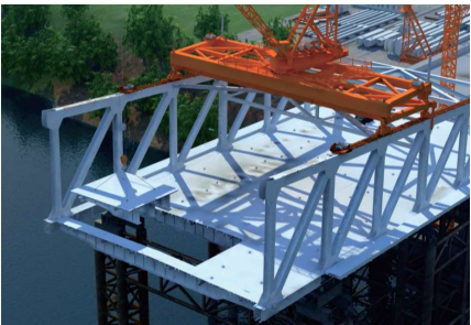
图4 桥面板划分及安装示意
