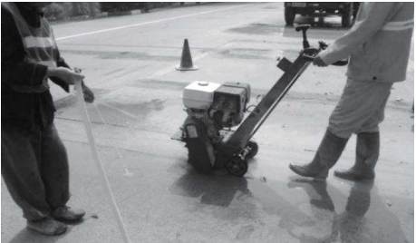
图 4 手推式铣刨机施工效果
