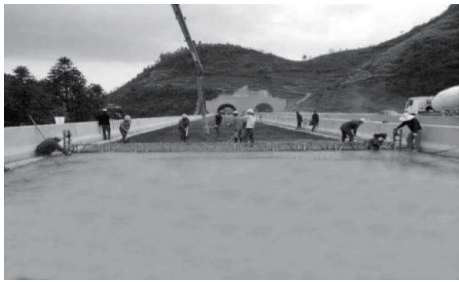
图 2 振动梁施工效果
