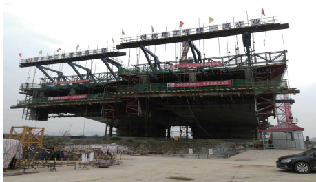
图6 挂篮悬浇施工现场示意图
