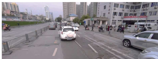
图 3 施工管理不当导致地面标线缺失或错乱
