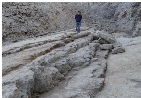
图3 挡墙基槽开挖后基底图
