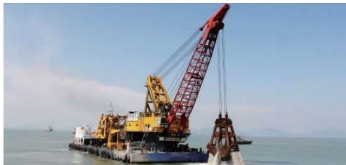
图 4 疏浚工程之实景
