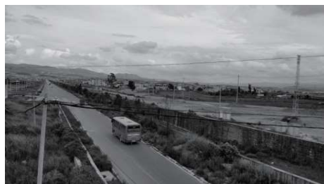
图5 西段分离式路基现场照片
