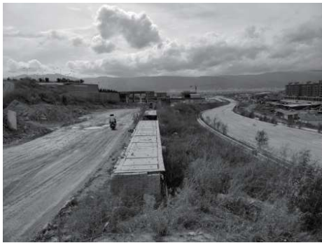
图 9 东段分离式路基现场照片
