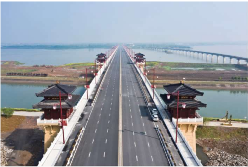
图 6 海子湖特大桥建成实景图
