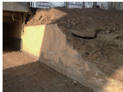
图 1 原黄河路下穿京沪铁路地道外侧砖砌挡墙
