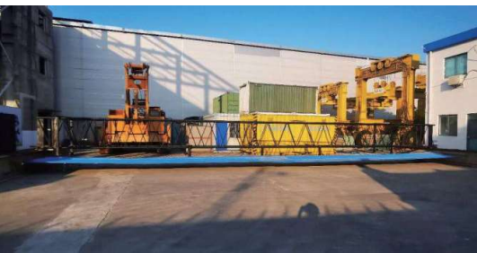
图8 防护棚场地内承载力试验
