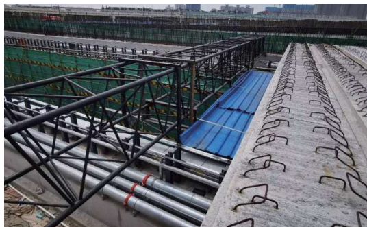
图10 工作状态中防护结构主体
