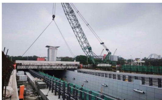
图12 预制板梁现场吊装
