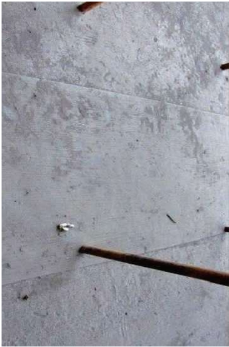
图 4 快易收口网模板的后浇带施工完成示意图
