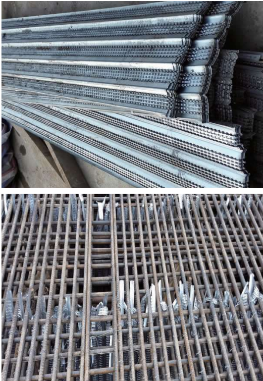
图 1 快易收口网模板结构及安装完成示意图
